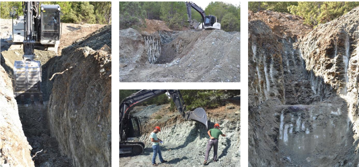
Şekil 2. Arazide yapılan yarma çalışmaları.
