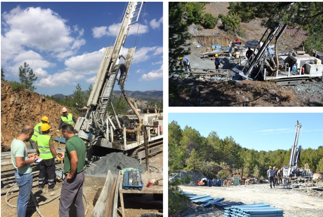
Şekil 3. Sahada yapılan sondaj çalışmalarından görüntüler.
